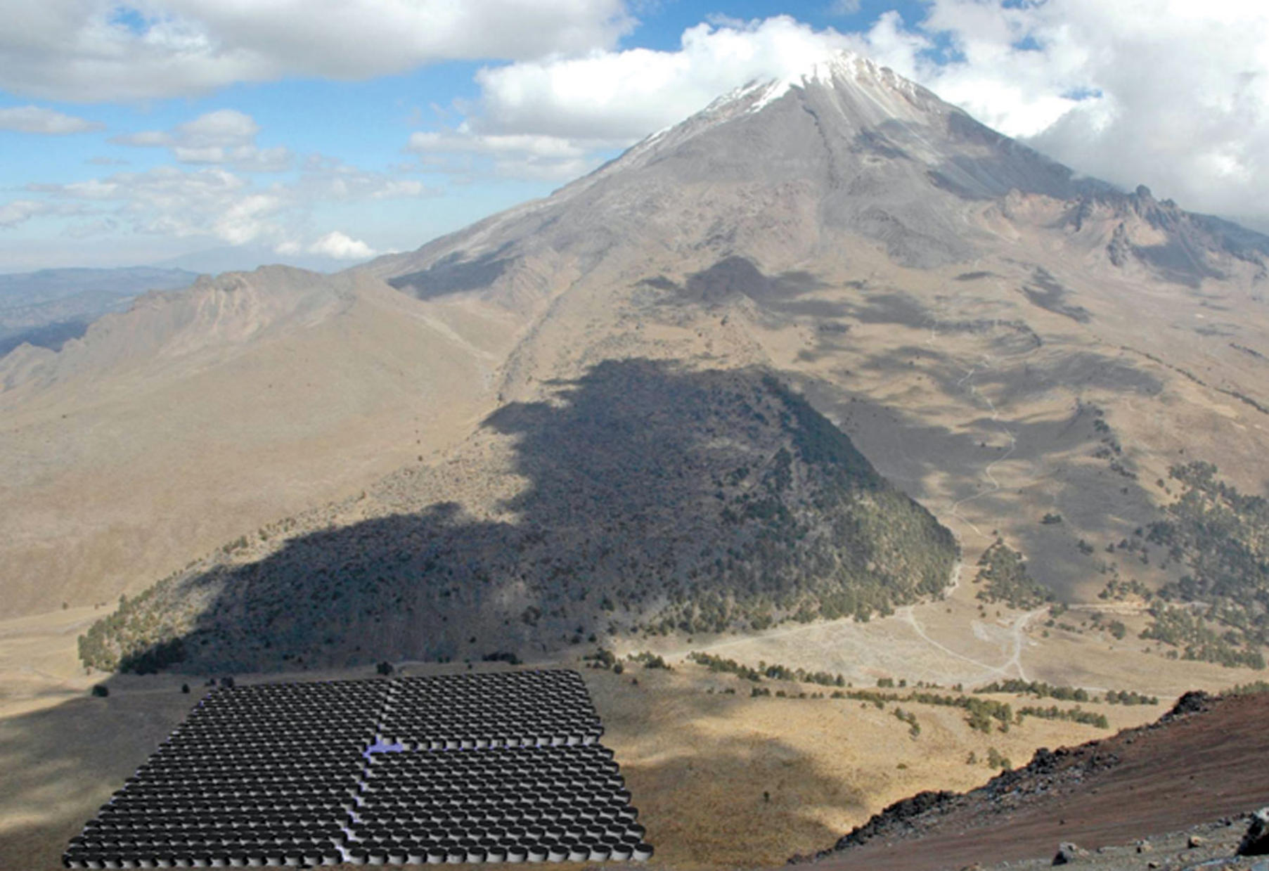
Гамма-телескоп HAWC в Мексике, 160 \times 160 \text{ м}^2 , на высоте 4100 м.
